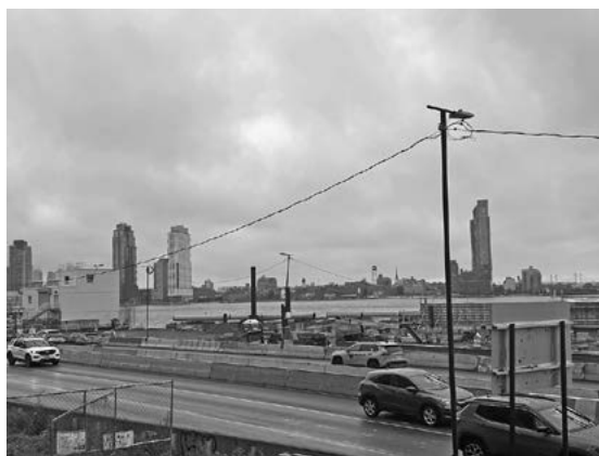
図7 ESCRの工事現場 現在もFDRドライブ沿いで建設が進められている (2026年7月著者撮影)
