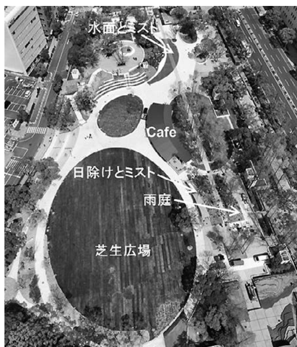
図6 様々な異常高温対策が導入された東遊園地の再整備状況（神戸市提供）
