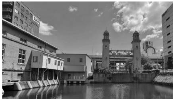
図12 松重閘門及び旧松重ポンプ所の外観
