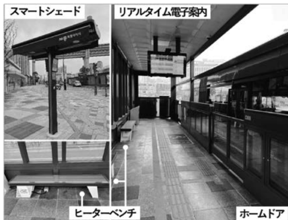
図6 交差点やBRTステーションの新設備
