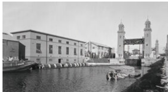
松重ポンプ所(左の建物)と松重閘門
