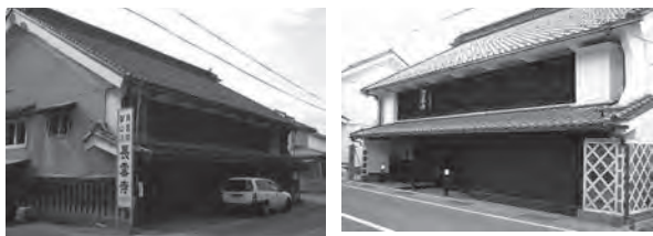
写真2 「蔵し館」再生前後の外観（左が再生前）
