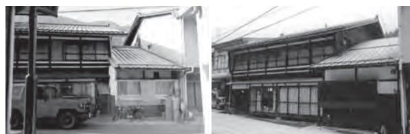
写真1 S家住宅再生前後の外観（左が再生前）
