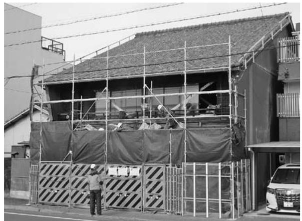
図36 解体現場（正面下屋の瓦撤去）
