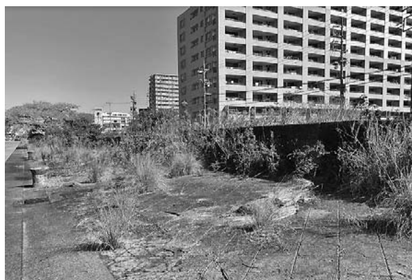
写真-1 護岸背後のマンション
