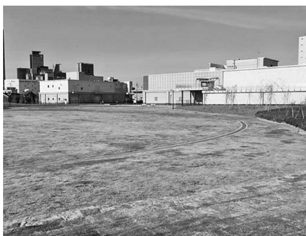
図3 露橋下水処理場の上空利用「広見憩いの杜」
