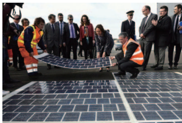
図 21 太陽光パネル敷設状況
