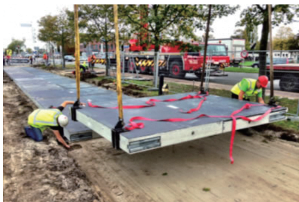
図 18 太陽光パネル敷設状況
