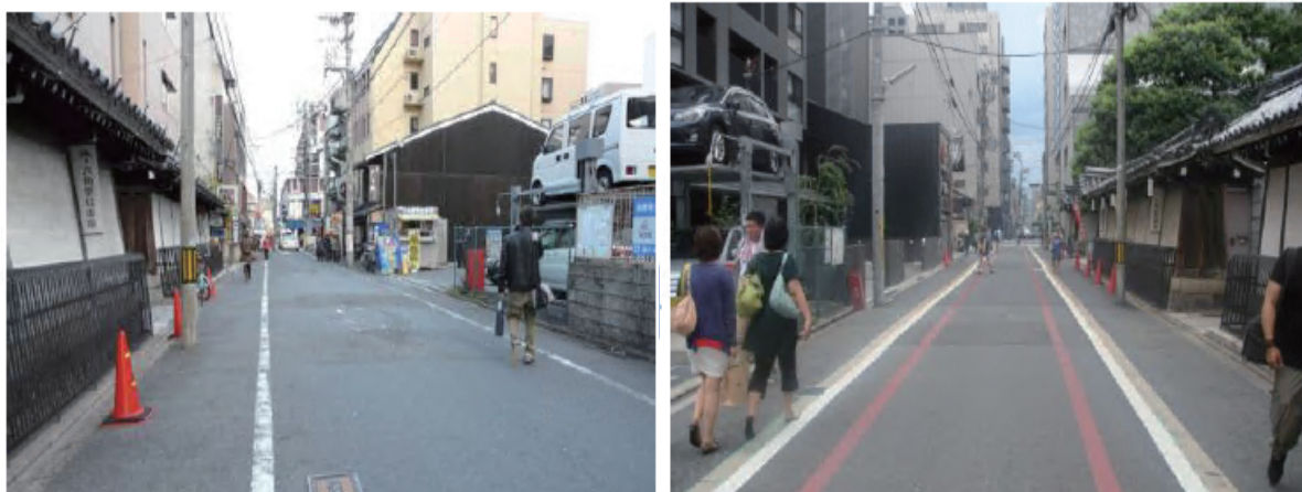
図 15 整備前後の状況写真（左ー整備前、右ー整備後）
