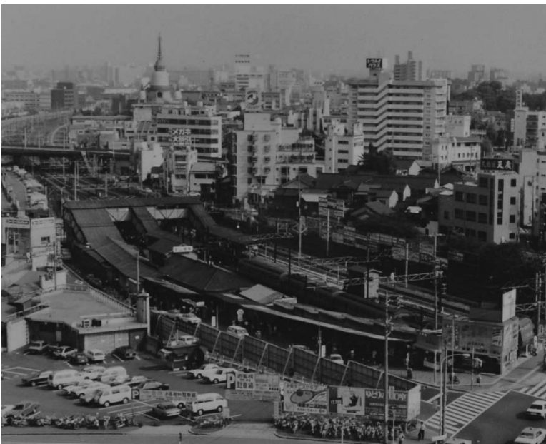
図14(左上) 名鉄金山橋駅(北西から東南方向を見る)
