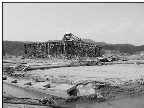
写真－10 大津波による被害状況
