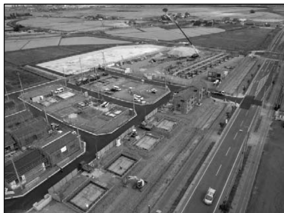
写真－１２ 防災集団移転促進事業状況 （名取市下増田地区）
