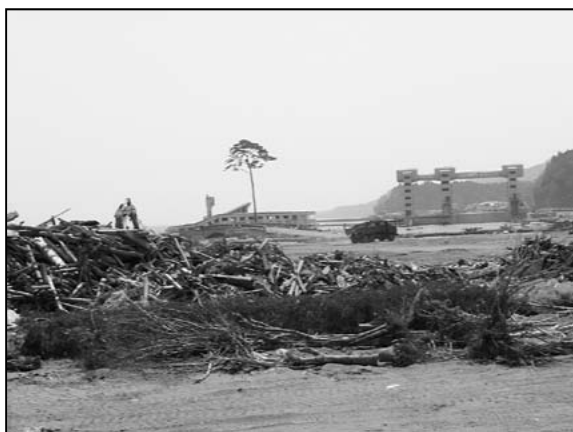
写真－9 大津波による被害状況
