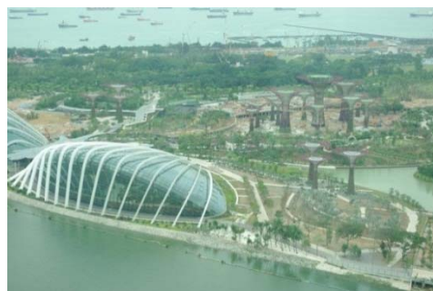
図 15 建設中のガーデンズ・バイ・ザ・ベイ
