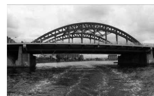
写真 3 中川橋（アーチ橋）
