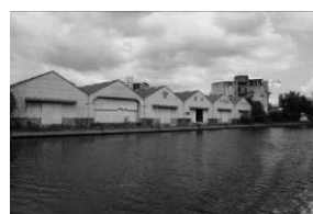
写真 4 昭和初期の倉庫
