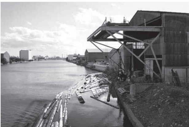
クレーン付倉庫（東海橋南側）
