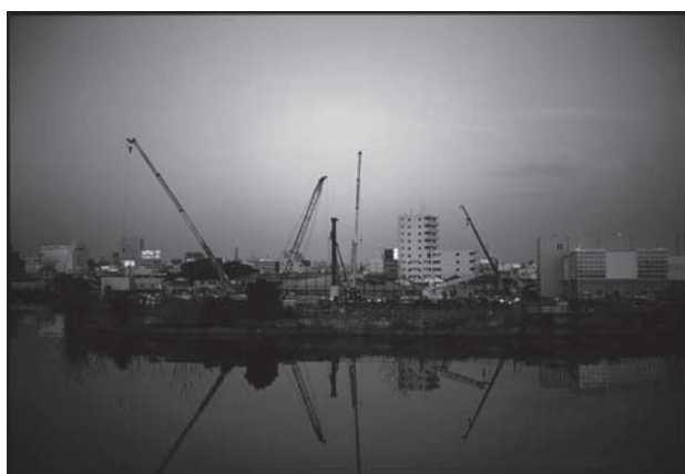
様々な角度で空を刻むクレーンのアーム （露橋水処理センター改築工事現場付近）
