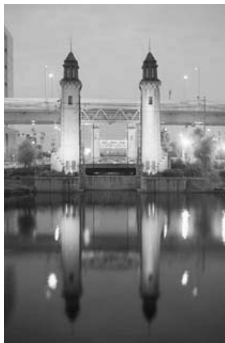
松重閘門ライトアップ
