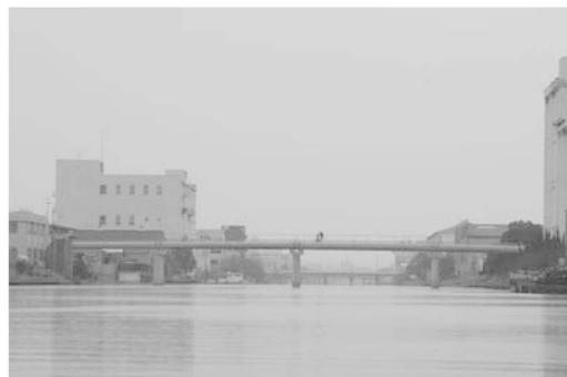
水管橋（東海橋～昭和橋）の橋桁
