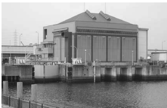
中川口ポンプ所
