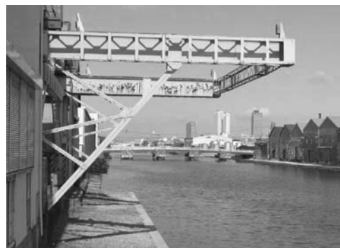
産業遺産（物揚場・荷役クレーン）
