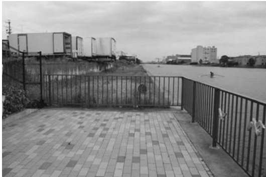
遊歩道の整備
