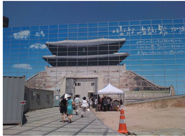
被災した南大門の修復現場仮囲い。中は見学できる
