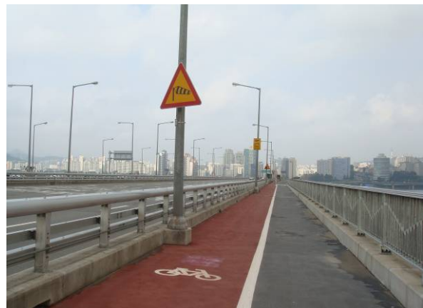
漢江・麻浦大橋の自転車道。自転車インフラも整備され始めている
