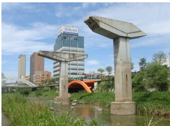
高架道路の脚柱の一部が残されている
