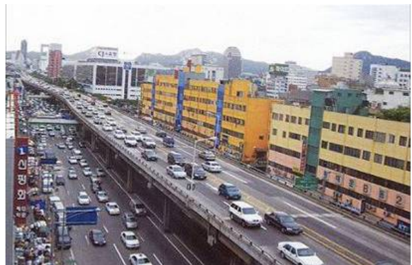
写真Ⅲ-2 復元前の清溪道路と清溪高架道路
