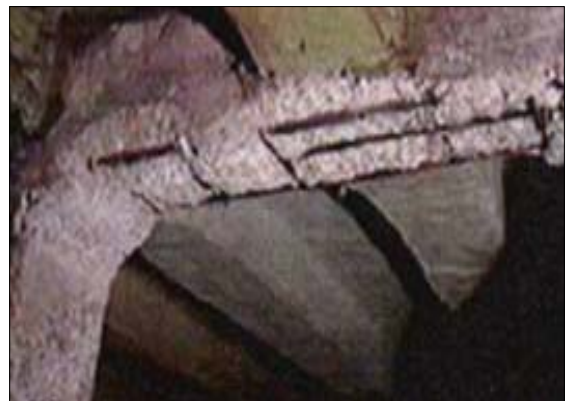
写真Ⅳ-(1)3 清溪道路の構造物の状況
