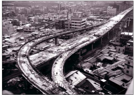
写真Ⅳ-(1)2 建設当時の清溪高架道路
