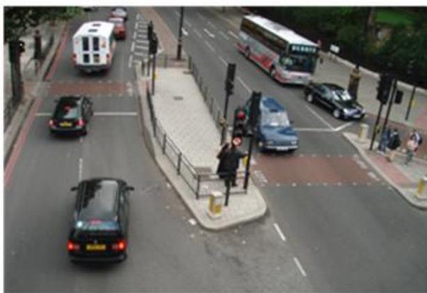
図 3-1 クランク型横断歩道構造(ロンドン市)
