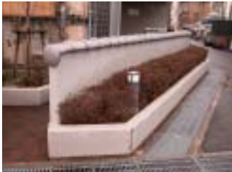
意匠に配慮された塀
