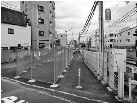
東池袋の路面電車沿い、都市計画道路・補助81号線。路面電車の両側に決定されていた都市計画道路が着工した。周囲は東京の木造密集市街地の代表例であり、狭隘道路のみで、公園もない。沿道で建物更新が劇的に進行中。
