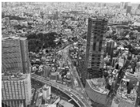
豊島区東池袋の上空から南側（高田馬場、新宿方向）を俯瞰 補助81号線に接続して、環状5号線の2（明治通りのバイパス）が着工した。右手の高層建築物は、マンションと合築した豊島区役所（隈研吾の設計）。周囲では、連鎖的に再開発が具体化し始めた。
