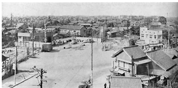
放射3号線 目黒区柿ノ木坂附近 （環状7号線、放射3号線立体交差箇所）
