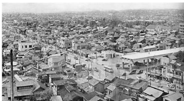
環状7号線と青梅街道立体交差工事中 都市計画の実施は沿道の土地利用を大きく変化させる力を持つ。
