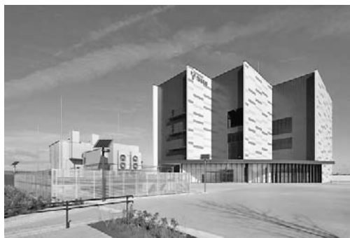
図2-2 エネルギーセンター
