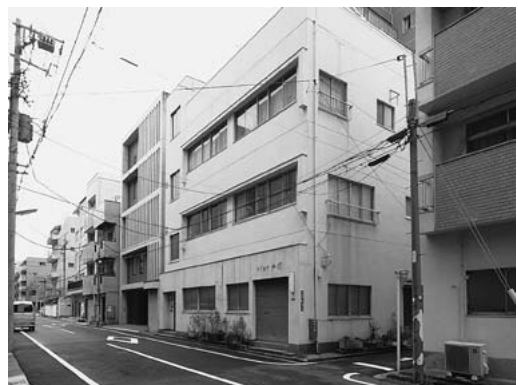
写真2 リノベーション前の建物外観
