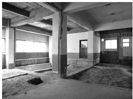
写真3 工事中の内観
