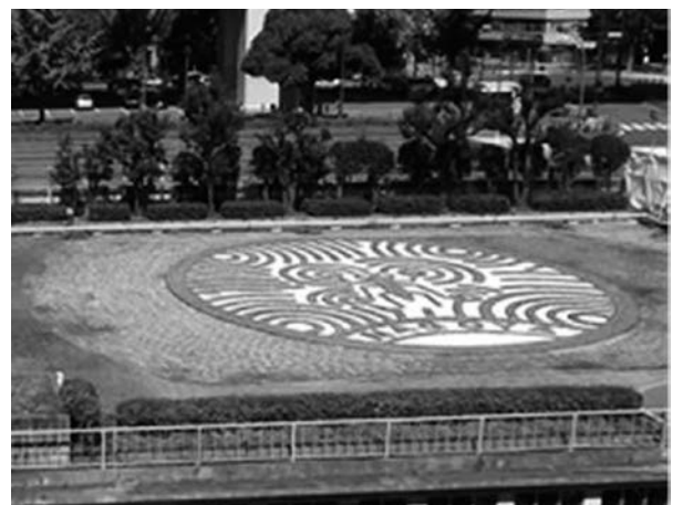
写真7 堀留水処理センター
