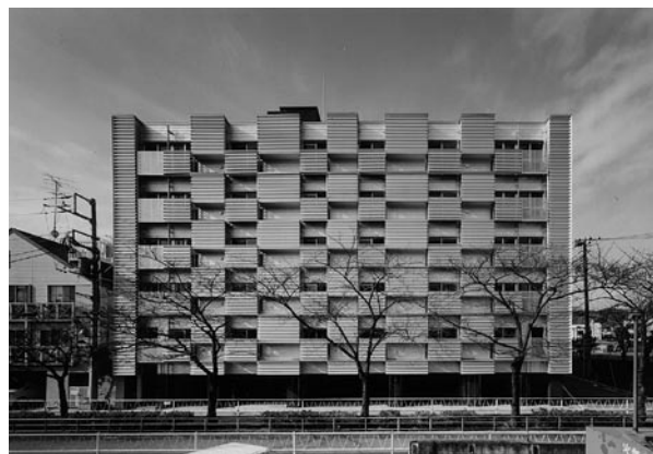
写真5 リファイニング後外観
