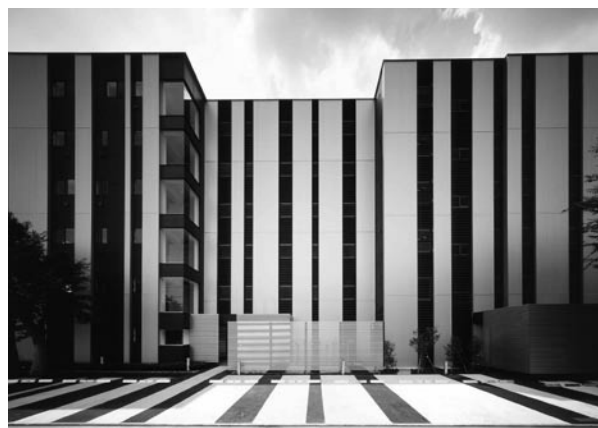
写真7 リファイニング後外観
