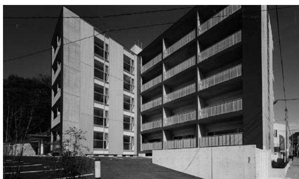
写真2 PARK SIDE GARDENリファイニング後外観
