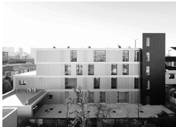
写真9 リファイニング後外観
