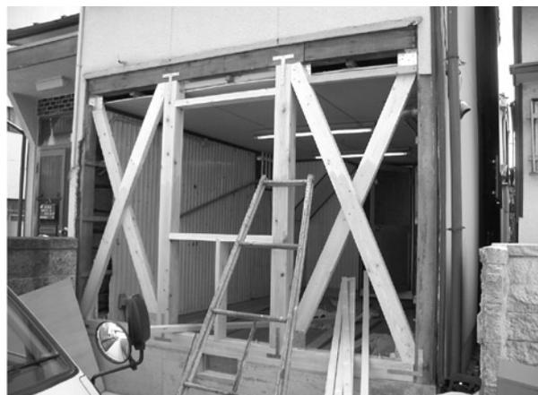
写真1 耐震改修の例
