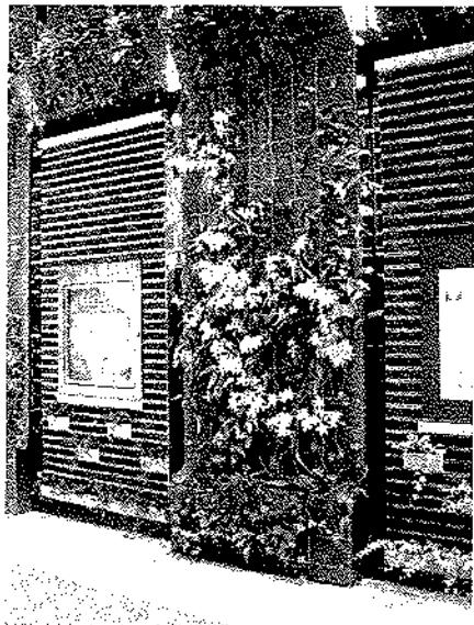
写真-6 掲示用ウィンドウを組み込んだコケの緑化パネルとツル植物の緑化パネル
