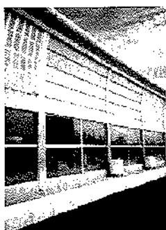
図4 光触媒吸音板による防音壁
