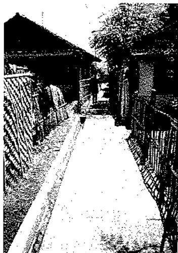
写真：KIP実施後～雨季でも使える舗装道路と排水路が整備された
