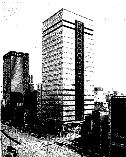
錦パークビル 構造・階数：S造（一部SRC造）、地上24階、地下4階建 主要用途：住宅(16戸)、店舗、事務所、変電所、社務所、駐車場
