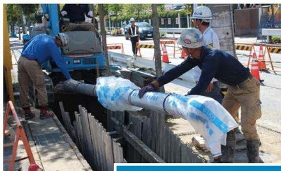
配水管を新設する際、老朽化を更新する際にはすべて耐震管を使用しています。
