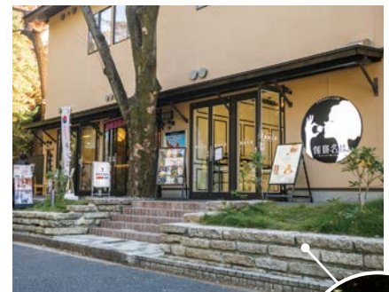
正面南エリア建物部分の土留めには、市電の軌道敷石が再利用されています。
