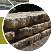
正面南エリア建物部分の土留めには、市電の軌道敷石が再利用されています。
