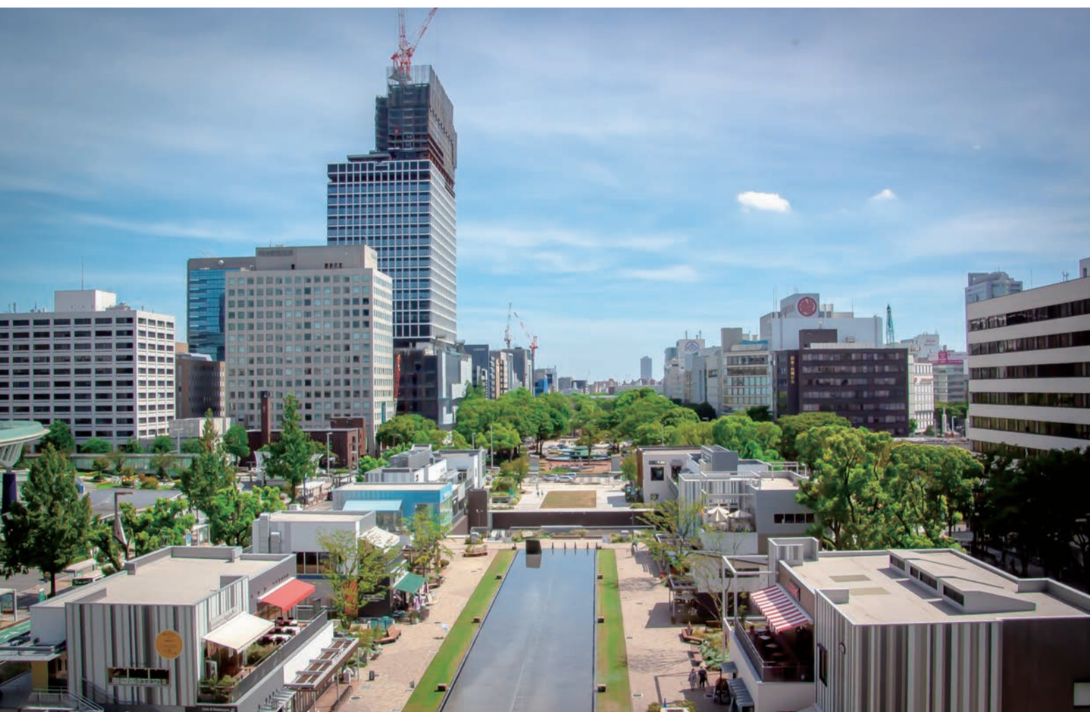
久屋大通の街並みの中に、存在感を表す建設中の中日ビル
