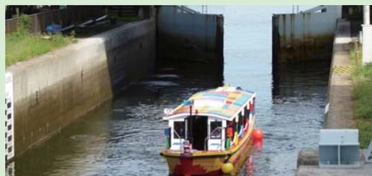
中川口通船門の閘室。ここで水位を調節して船を航行させる。
