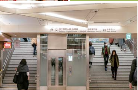
全国の地下街で初の斜行エレベーター（定員9名）。誰にとってもやさしい地下街をかたちにしたもの。大きな荷物を抱えた訪日観光客が利用することも。
