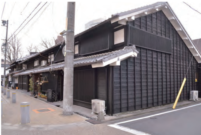
明治時代建築の長屋を改修
