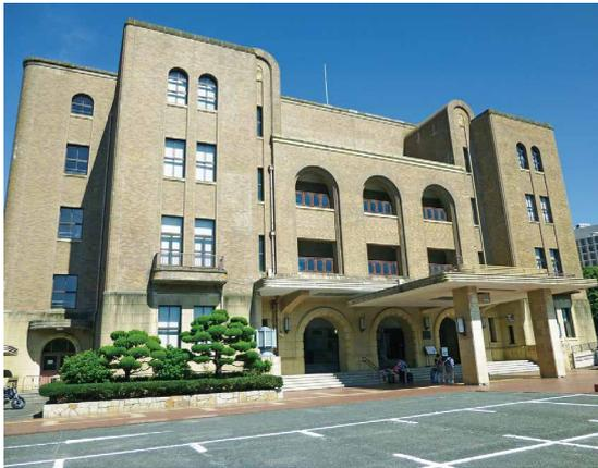
建物の構造は地上4階、地下1階の鉄骨鉄筋コンクリート造で、大ホールと4階ホール、9室からなる集会室等で構成されています。
