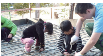
基礎工事に参加した際の様子
