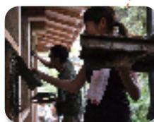
発酵させてあった**荒土**に、残りのワラと水を追加して再度足で**泥こね**をし、**コテ**で**壁塗り**を開始しました。トイレアイデア提案で出された**月・星・太陽**を壁の上に**明かりとり**として作成しました。
