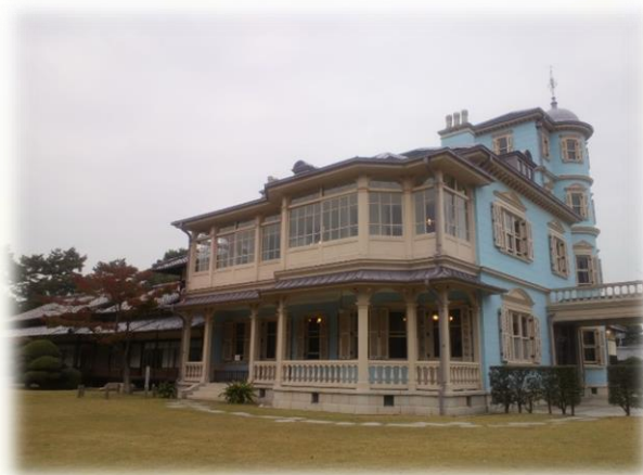
六華苑洋館(南側から)
