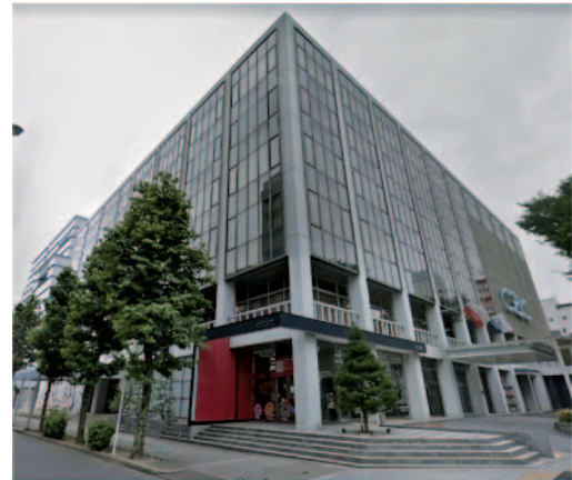
写真 2-1 中部日本放送本社ビル (GoogleMap より)
