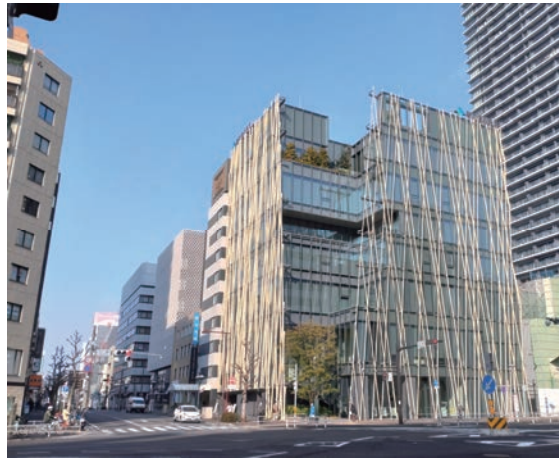
図 3-5 ファサードに木を取り入れている建物事例（碧海信用金庫 御園支店）
