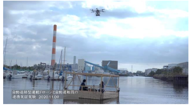
写真 5 自動追跡型運搬ドローンと 自動運転筏の連携実証実験（竹中工務店他）
