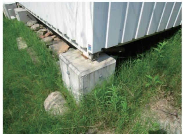
写真3 コンテナの基礎部分
