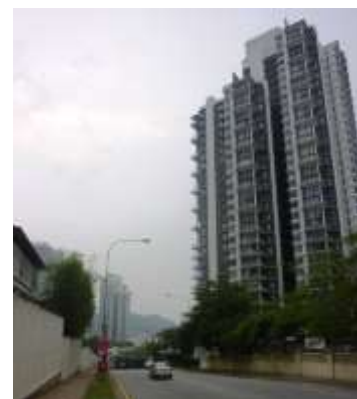
図 15 モントキアラ地区のコンドミニウム
