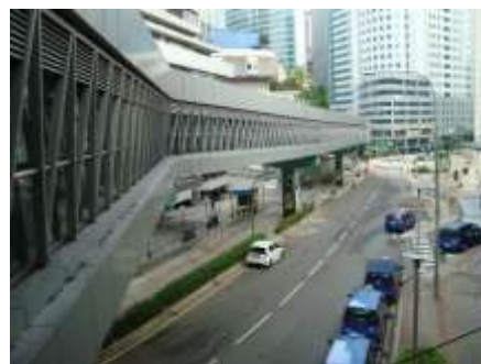
図 12 大型商業施設からペトロナス ツインタワー方面を結ぶ ペDESTロリアンデッキ
