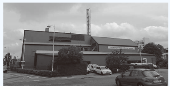
図 サザンプトンのエネルギーセンター
