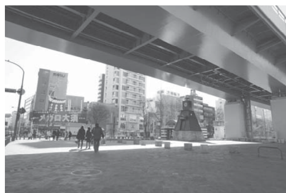
写真2 若宮大通の高速道路高架下
