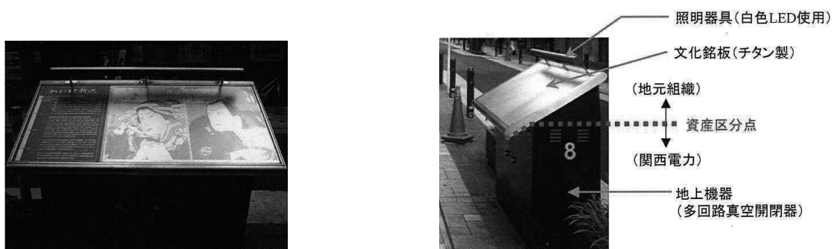
写真8 歩道の電力機器を有効活用した例
