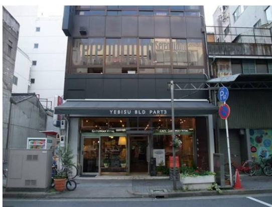
写真 3-1 ぬびすビルパート3
