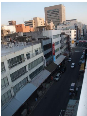
写真 3-3 地区内側の中層建物群
