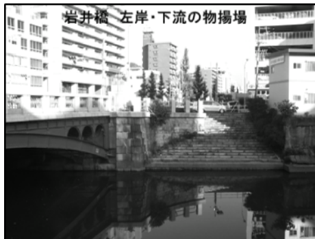
NO.13 岩井橋 東・南側
