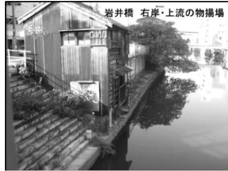
NO.10 岩井橋 西・北側
