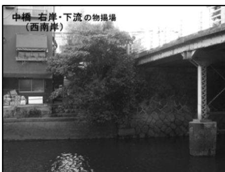
NO.5 中橋 西・南側
