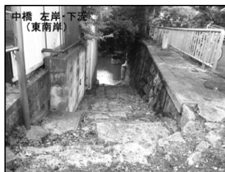
NO.6 中橋 東・南側
