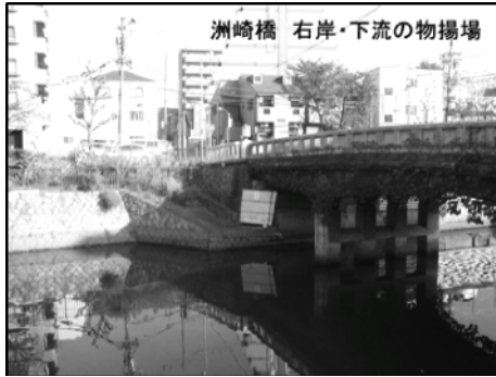
NO.9 洲崎橋 西・南側
