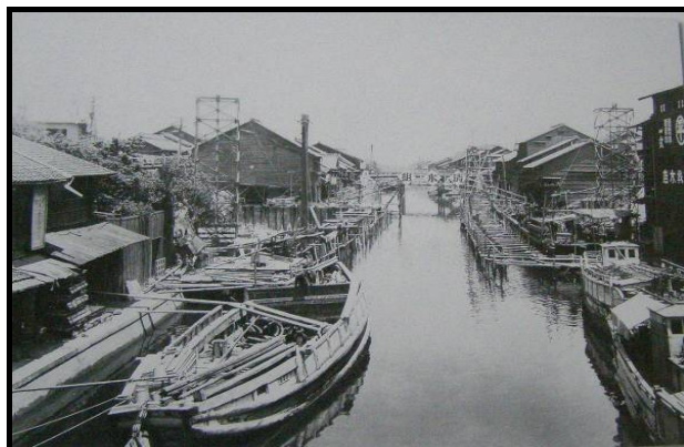
中橋から建設中の桜橋を見る・昭和10年頃 (名古屋今昔写真集)
