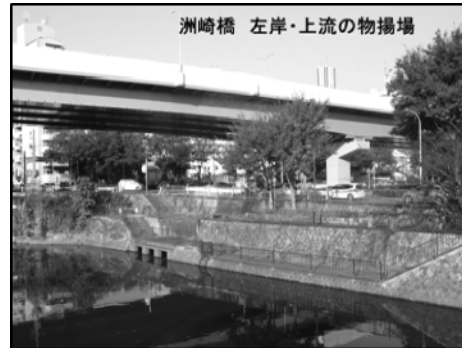
NO.8 洲崎橋 東・北側
