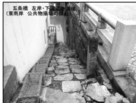
NO.4 五条橋 東・南側
