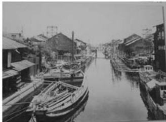
図4 中橋から建設中の桜橋をみる 昭和10年頃(出典:名古屋今昔写真集)
