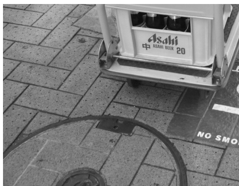
図4-6 台車の振動が多く進みにくい歩道
