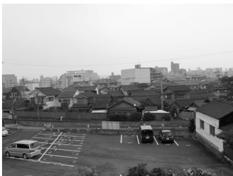
(呼続地区の住宅密集地の俯瞰写真)
