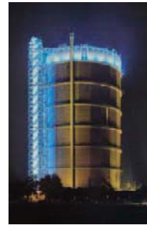
展示ホールや展望台に活用されている旧ガスタンク 出典：ガソメーターHP
