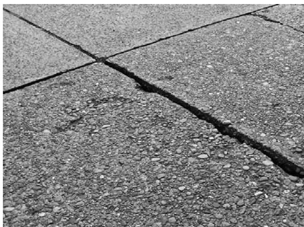
写真2 目地材の飛散
