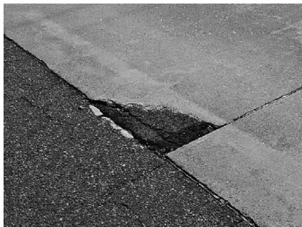
写真3 版の角欠け(アスファルトで応急措置)
